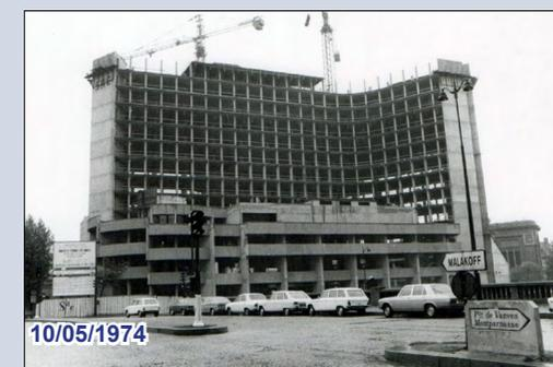
Les châssis vitrés modulaires pré-fabriqués fermant aux vents les ailes de la tour sont par la suite installés sur les allèges en béton armé. À la fin de l'année 1974, le clos et le couvert du nouveau siège de l'INSEE sont achevés, permettant à l'équipe de maîtrise d'oeuvre de concentrer son activité de l'année 1975 sur les aménagements et les équipements.
