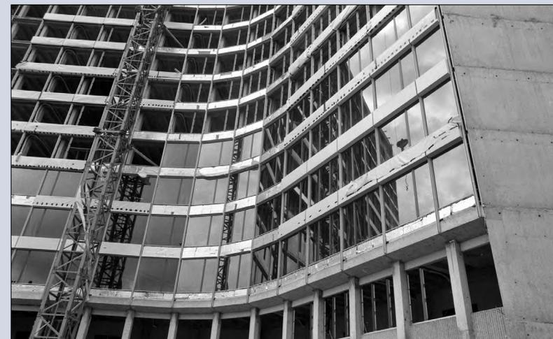
*Installation des châssis modulaires constituant les bandeaux vitrés concaves rythmant les façades du tripode central.*
